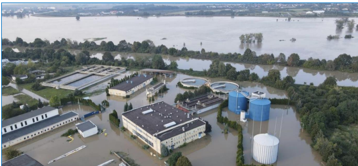
Zdjęcie. Zalana oczyszczalnia ścieków w Brzegu [fot. UM Brzeg]
